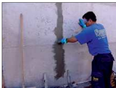
Grietas son simplemente tratados con una capa de mezcla de Penetron
