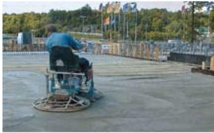
**Penetron Plus es aplicado espolvoreado a la superficie y después difundido al pasar platacho o helicóptero para afinar la superficie**
